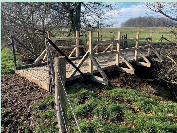
Une passerelle à bétail en acier-bois permettant le passage du bétail de part et d'autre de la rivière. Le bois pour la construction des deux ponts provient des forêts du triage de Beckerich.
