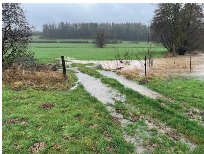
Ersetzen eines Betonrohres durch eine landwirtschaftliche Brücke. Das Rohr behinderte wegen seines engen Querschnitts den Wasserabfluss und wegen seines Höhenversatzes die Durchgängigkeit für die aquatische Fauna.
