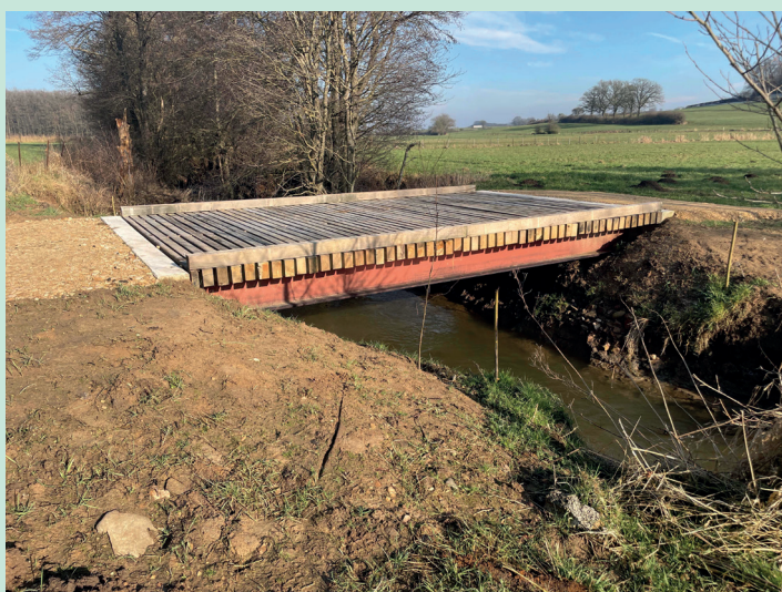
Remplacement d'une buse en béton par un pont agricole en acier-bois. Avec sa section trop étroite, le tuyau entravait l'écoulement de l'eau, de même que la libre circulation de la faune aquatique en raison de sa différence de niveau par rapport au cours d'eau.
